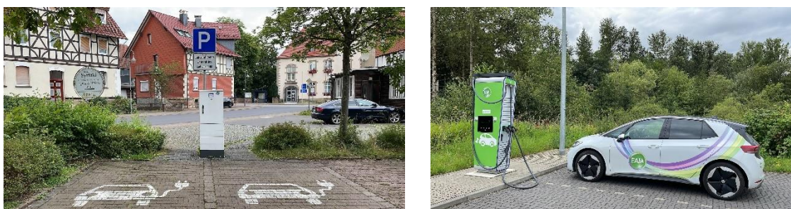
Abbildung 30: AC-Ladesäule Retteröder Straße (links), DC-Ladesäule Autohof (rechts)
