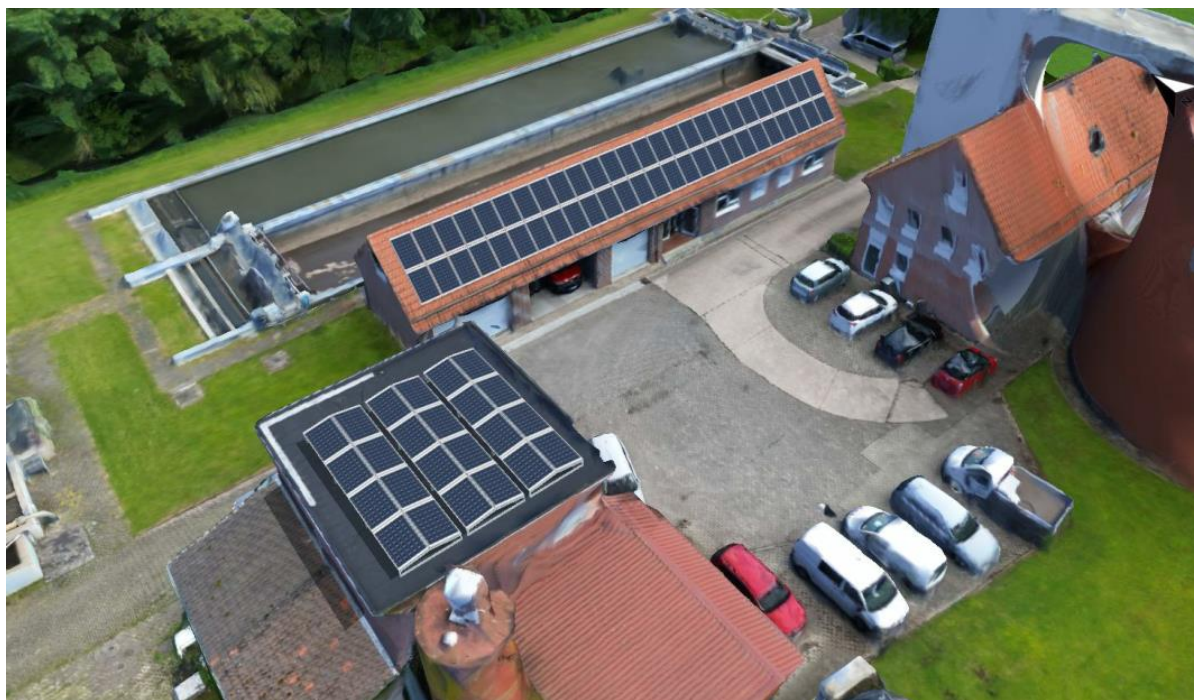
Abbildung 16: PV-Anlage Kläranlage Fürstenhagen mit maximaler Dachbelegung (33,8 kWp)
