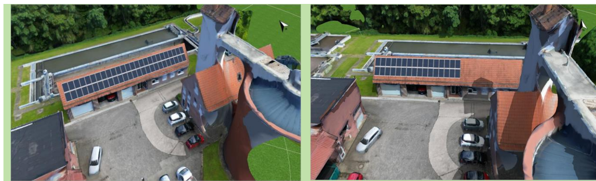
Abbildung 17: PV-Anlage Kläranlage Fürstenhagen mit Anlagengrößen von 23,1 bzw. 14,2 kWp
