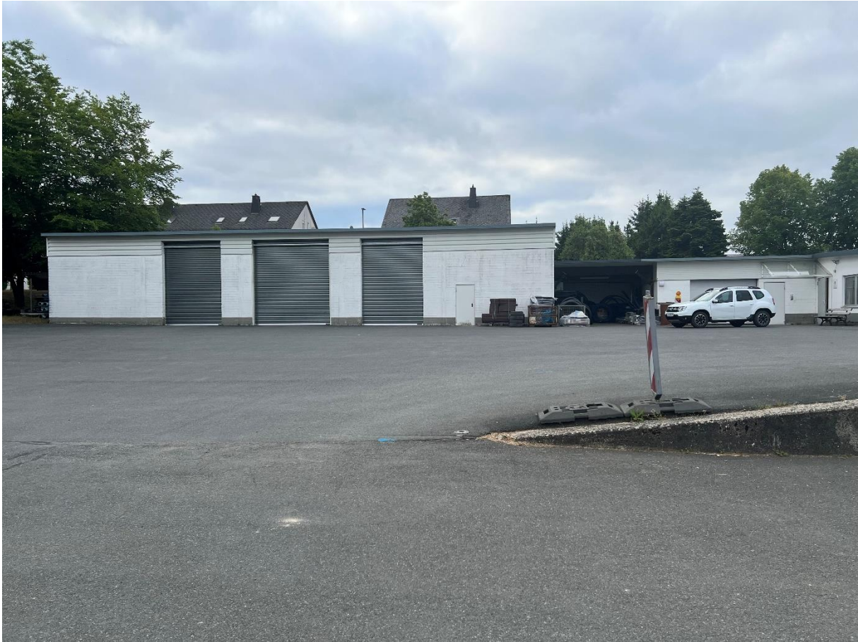
Abbildung 2: Bauhofgelände ohne Entwässerungseinrichtungen
