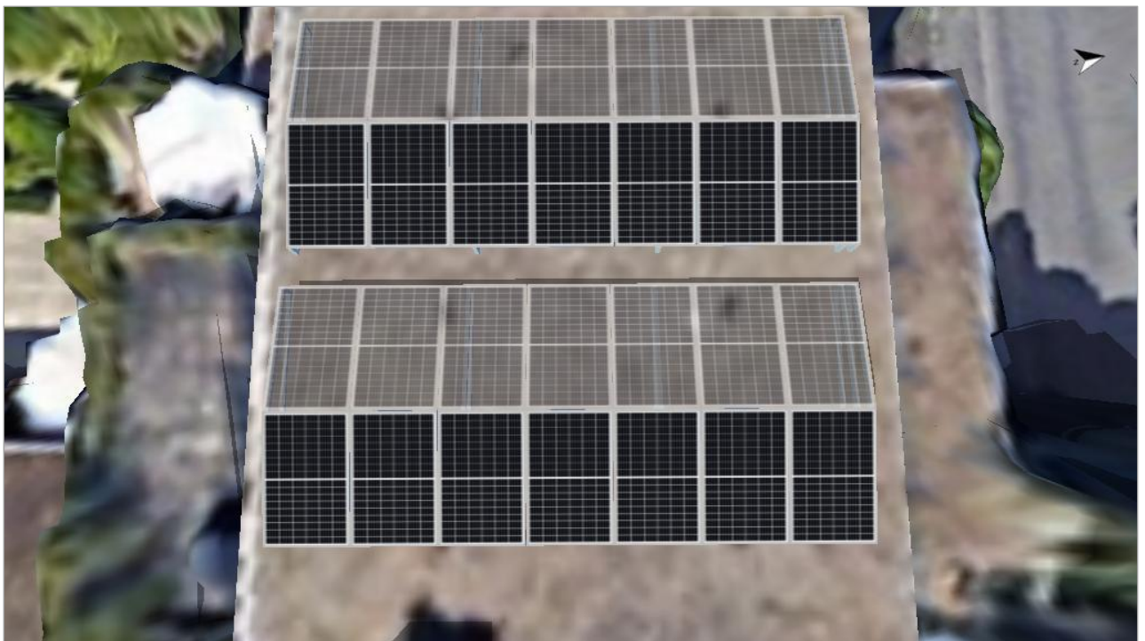
Abbildung: 1. Modulfläche - Gebäude 01-Modulfläche Ost
