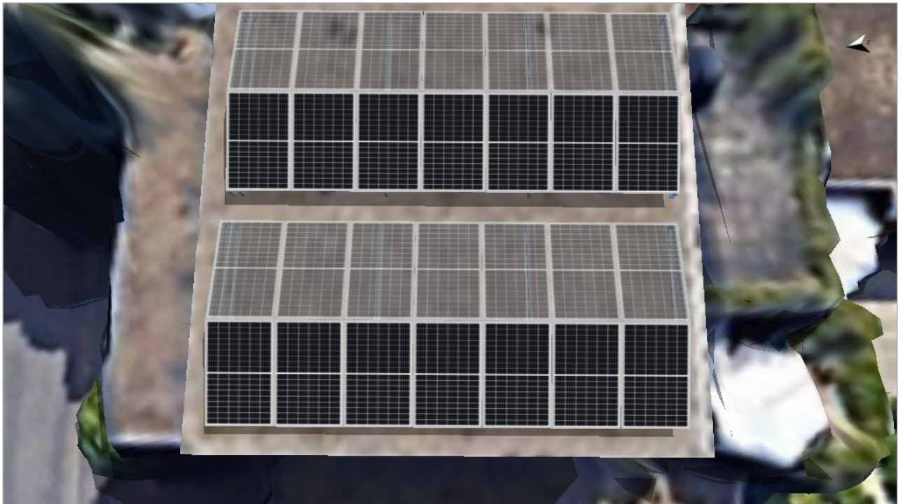
Abbildung: 2. Modulfläche - Gebäude 01-Modulfläche West
