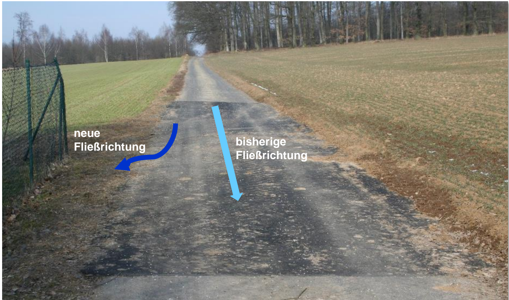
Änderung der Wegneigung zur Ableitung des Niederschlagswassers (© Stadt Altenstadt)
