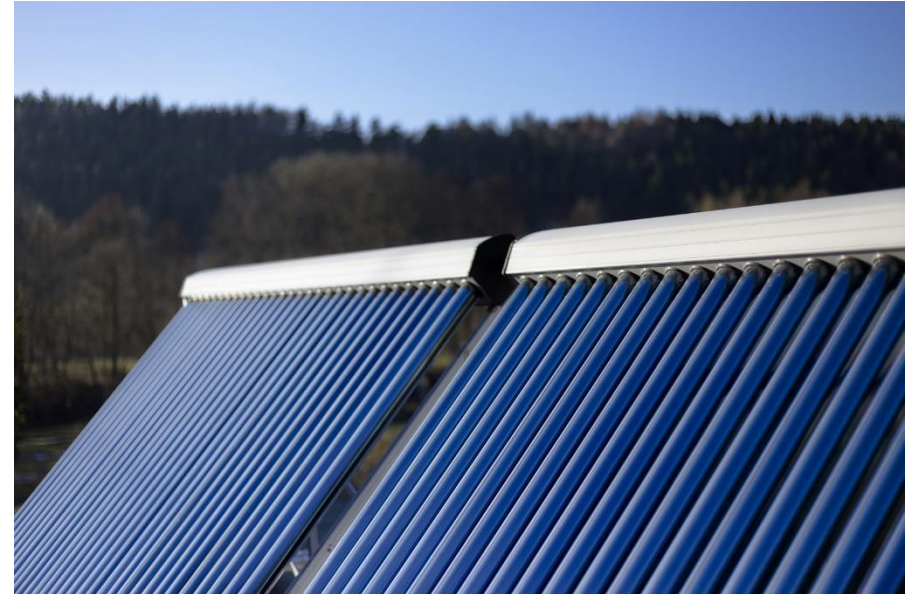
Solarthermie – hier Vakuumröhrenkollektoren
