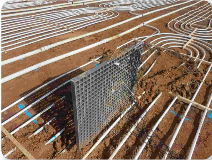
Einbau der Temperaturfühler im Kollektor
