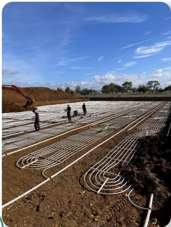
Bau des Kollektorfeldes (rund 5000m 2 )
